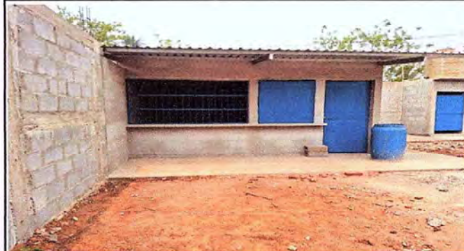
Foto 2: Construcción de Cocina
