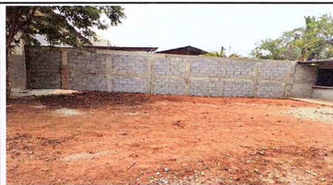
Foto 4: Construcción de muro perimetral lado izquierdo
