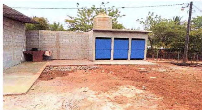
Foto1: Construcción de baño
