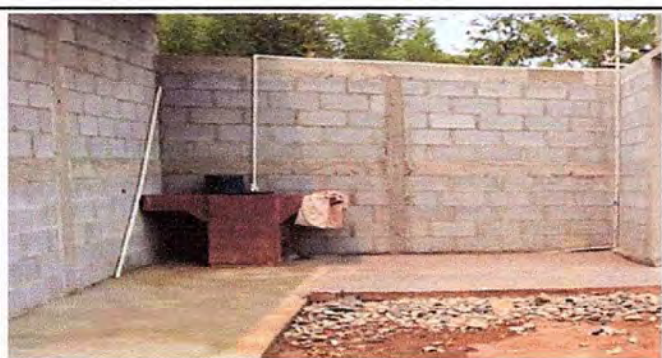
Foto 5: Construcción de muro perimetral lado derecho
