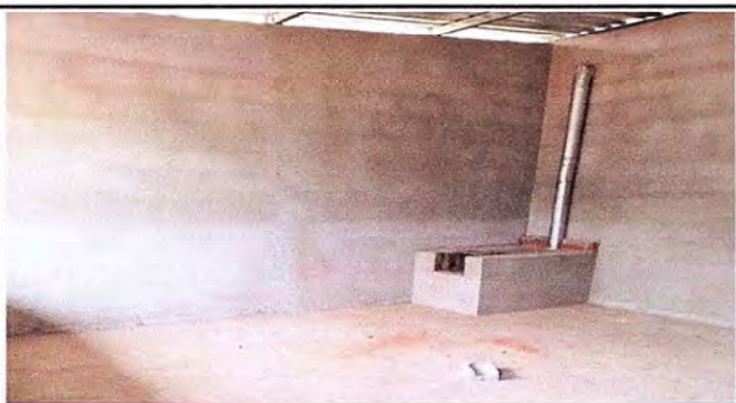
Foto 3: Construcción de plancha para polleton tres orillas
